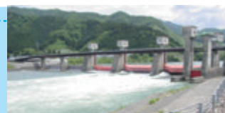
阿賀野川頭首工
