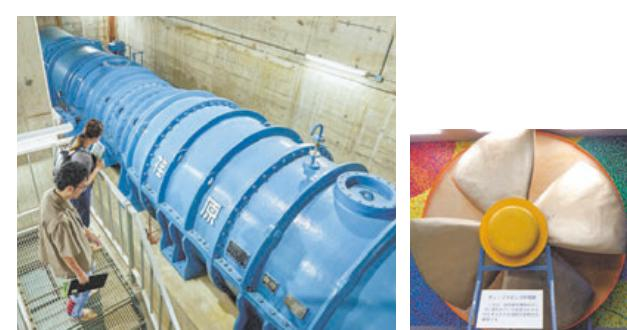
青い円筒に覆われた羽根車、ポンプの動きにより一気に排水される
