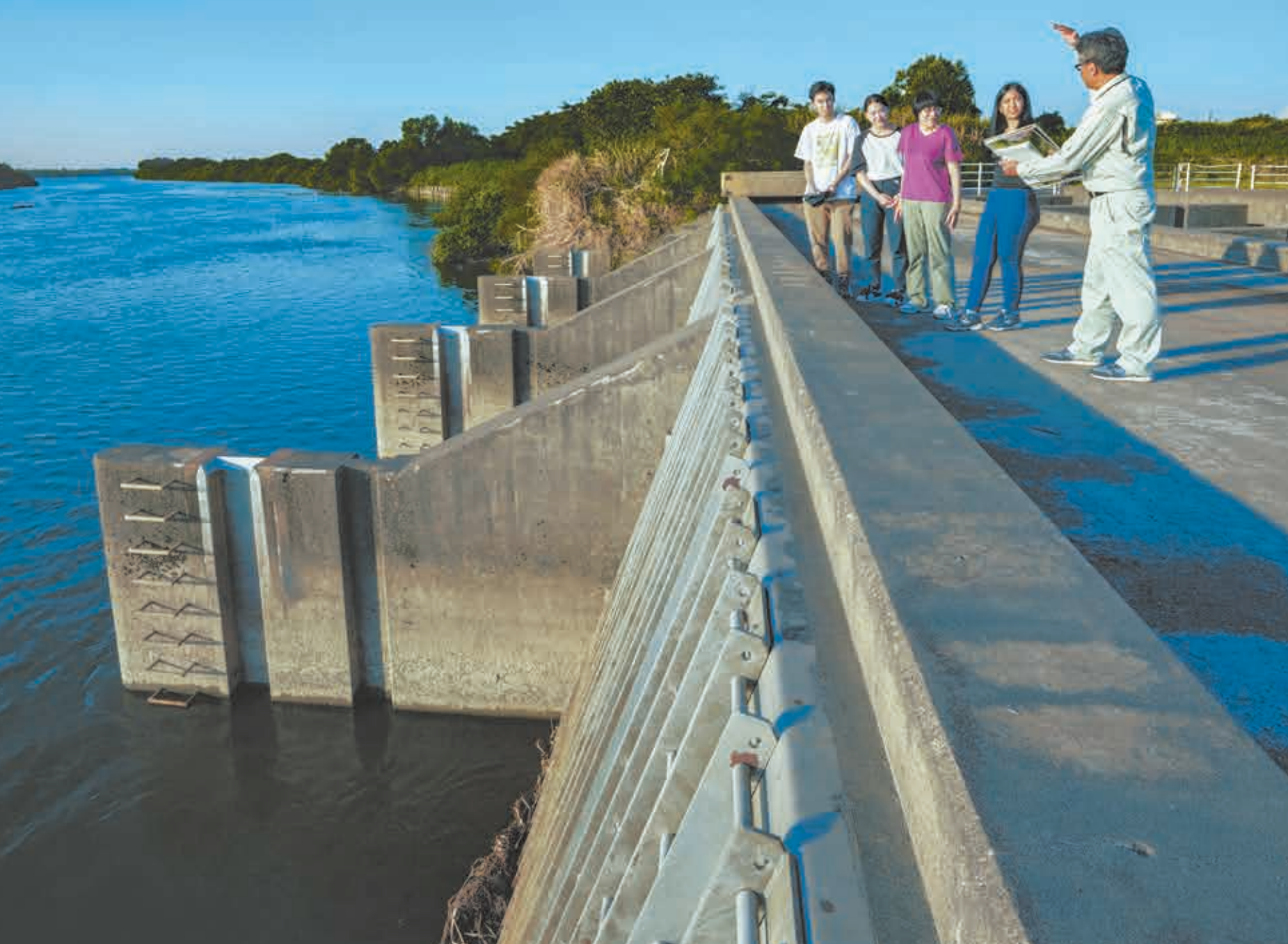
農地に水を送るため、水田揚水機場で取水している信濃川の河畔へ。新潟市秋葉区水田
