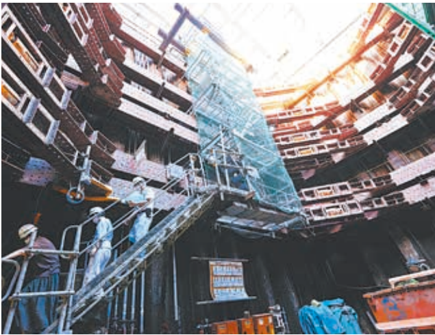
地下までは仮設階段を降りていく
