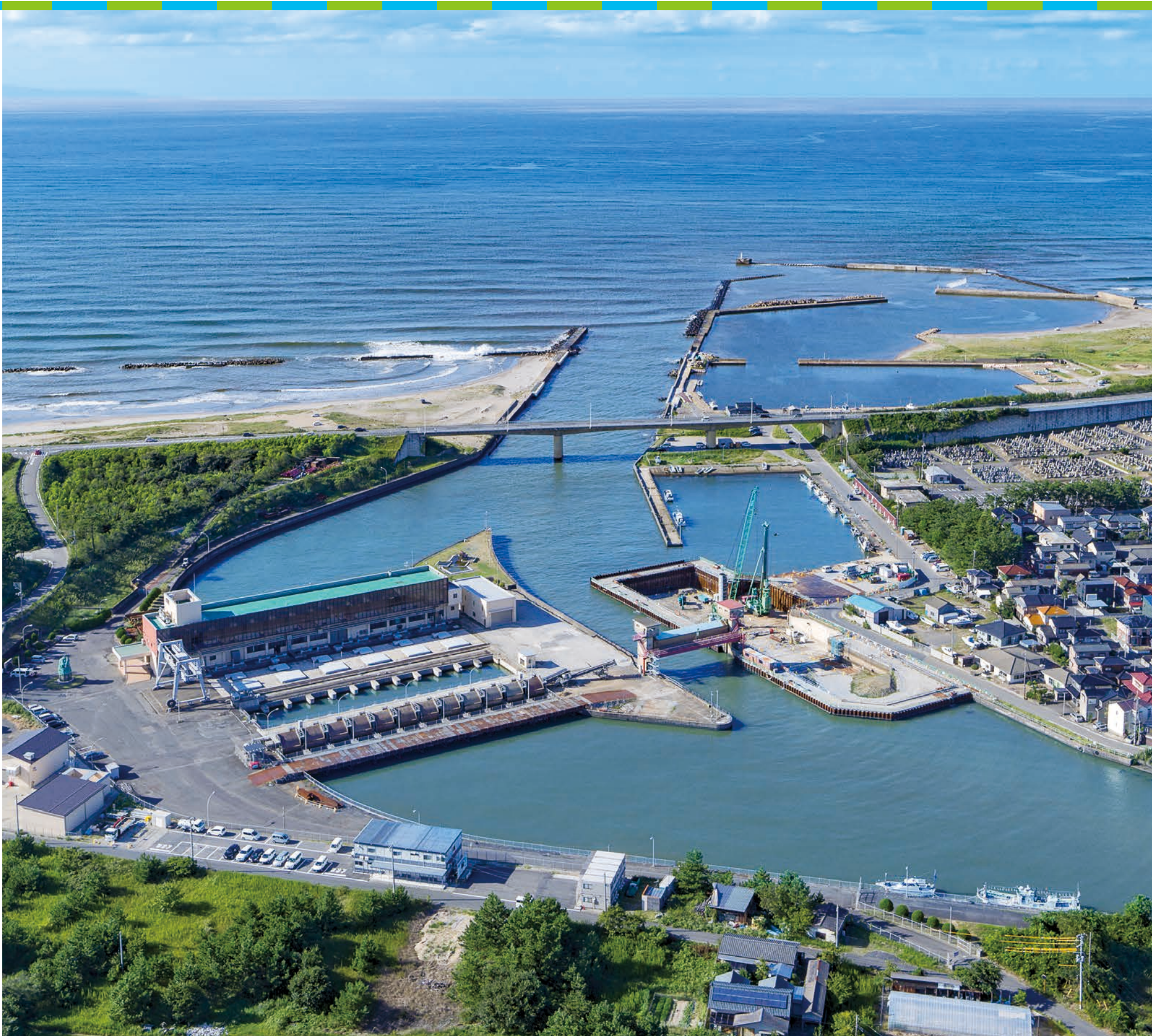
海のすぐそばにある「新川河口排水機場」と改修工事中の「新川河口自然排水樋門」
