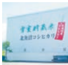
JAB北魚沼の低温貯蔵施設「雪室倉庫」は、雪の冷気を利用し、コメの鮮度を保ちます。「雪室貯蔵米」として販売され、好評です
