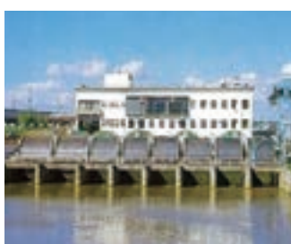
刈谷田川右岸排水機場
