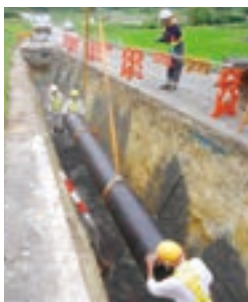
羽茂地区で進むパイプラインの敷設工事
