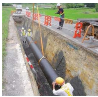
羽茂地区で進むパイプラインの敷設工事
