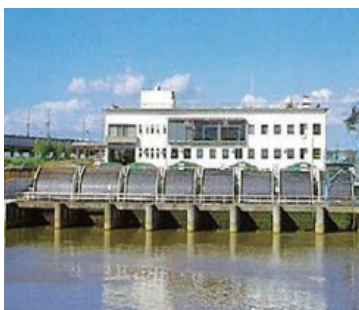
刈谷田川右岸排水機場
