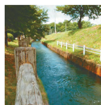
穀倉地帯を支える上江用水路。確実に農地へ水を届けるため、事業所では改修工事などに取り組んでいます。
