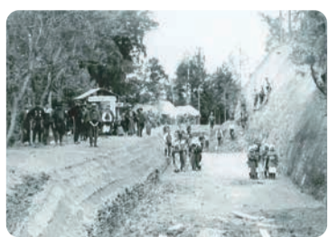
大正時代の上江用水路改修工事
