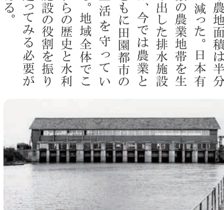
1948年に運転を開始した栗ノ木排水機場。亀田郷を乾田化に導いた(所蔵:亀田郷土地改良区)
